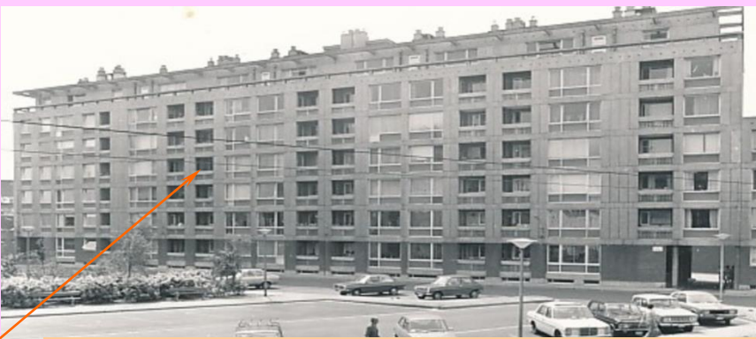
De appartementsblokken in de Cor. Sneyssonestr. in de zeventiger jaren.
