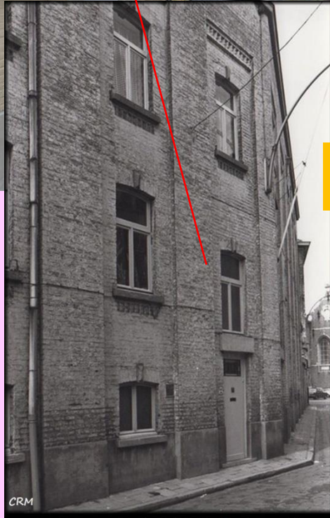
Gent, Schepenvijverstraat N°2, Fabrieksgebouw, 1977
