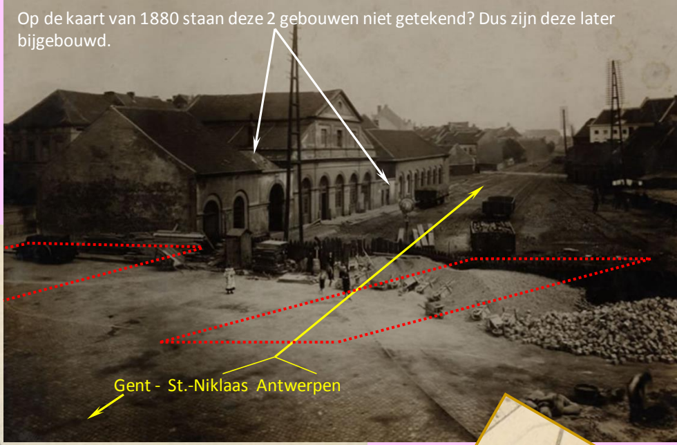
Voor de bouw v/h treinviaduct tussen 1909 en 1912 werd alles wat met rode stippellijn is omgeven gesloopt.
