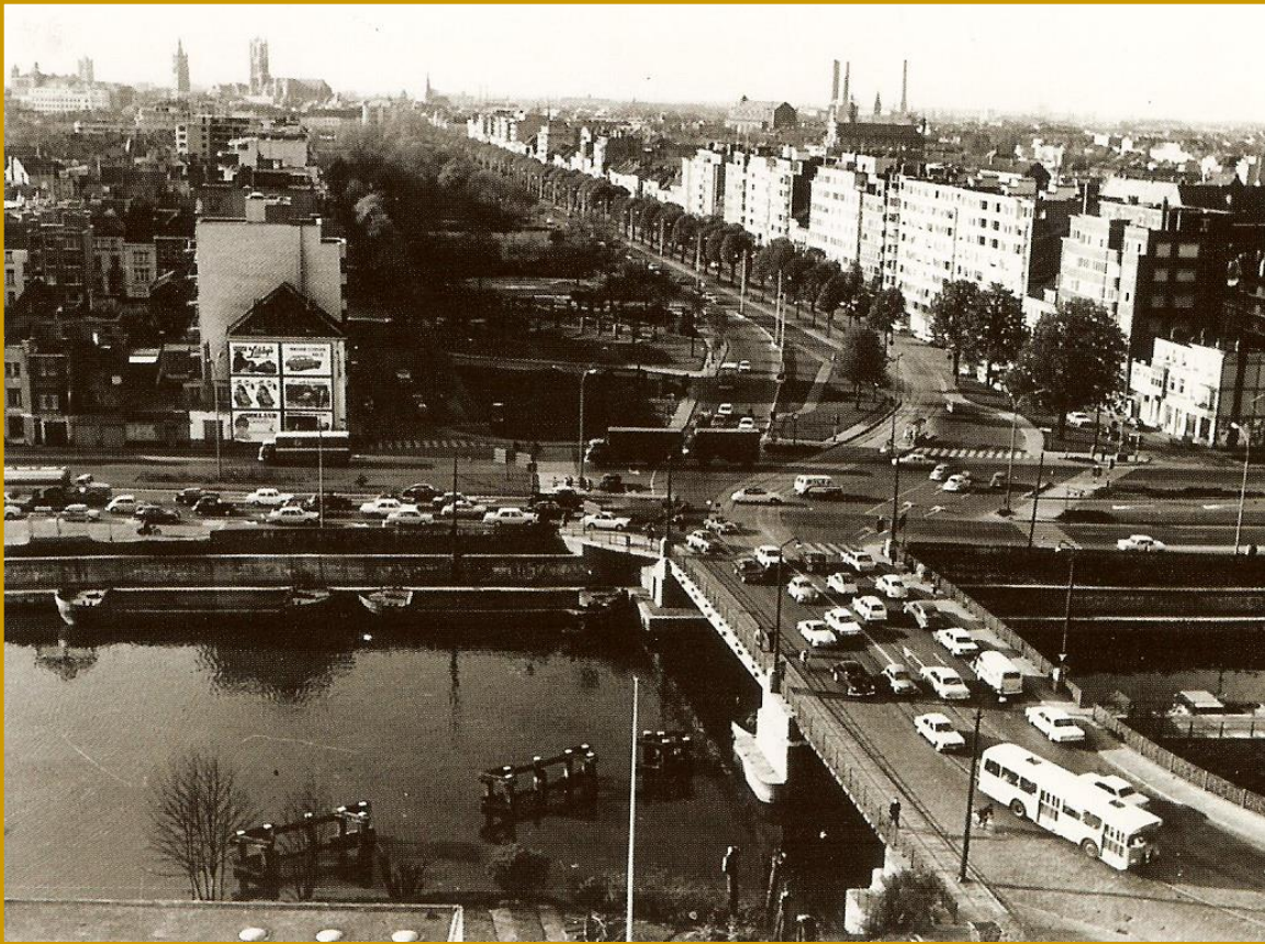
De St.-Lievensbrug met zicht op het Zuidpark in de jaren zestig. En rechtsboven de afbraak ervan in 1970.
