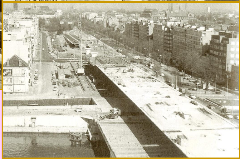
De bouw v/h autostrade-viaduct boven de St.-Lievensbrug in 1971.
