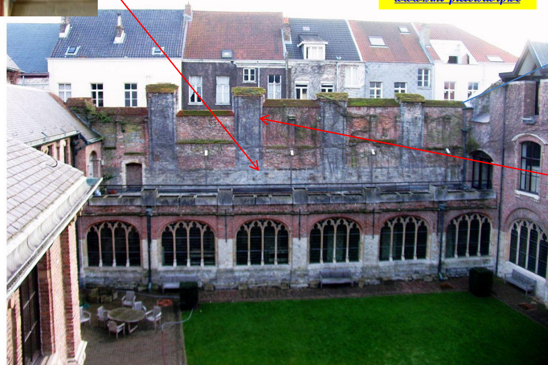
Het pand -- zicht van de achtergevels en tuin van de Jakobijnenstraat
