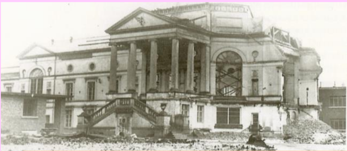
Gedurende W.O.I werd dit gebouw gebruikt als krijgshospitaal. Daarna een Hogeschool voor Arbeid. Kwam in verval tijdens W.O. II en de sloop gebeurde in 1945
