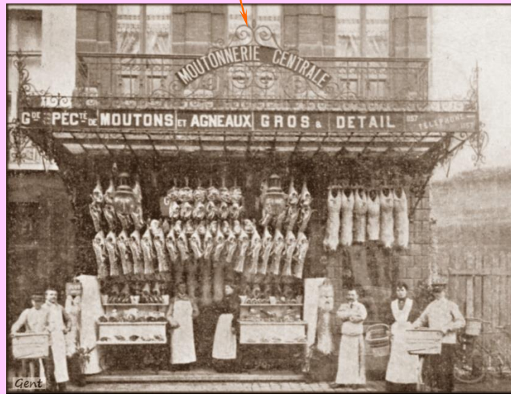
Gent, Sint-Michielsstraat N°27, Grande moutonnerie centrale, 1907
