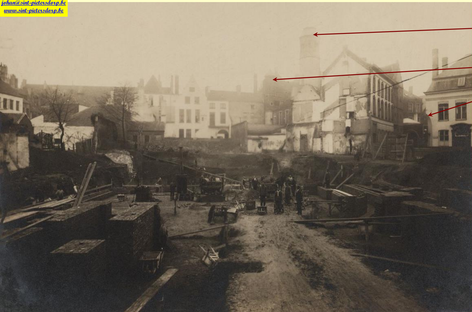
Foto dec. 1897 - De funderingswerken voor de aanleg v/h Vlaams Theater aan het St.-Baafs- plein.
